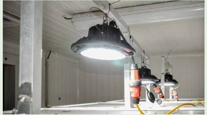
Highbay-ledlampen boven de vliegkooien
